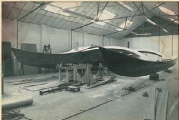
La construction de TAHITI DOUCHE au chantier Starberry d'Ipswich (GB) (photo Daniel Charles)
